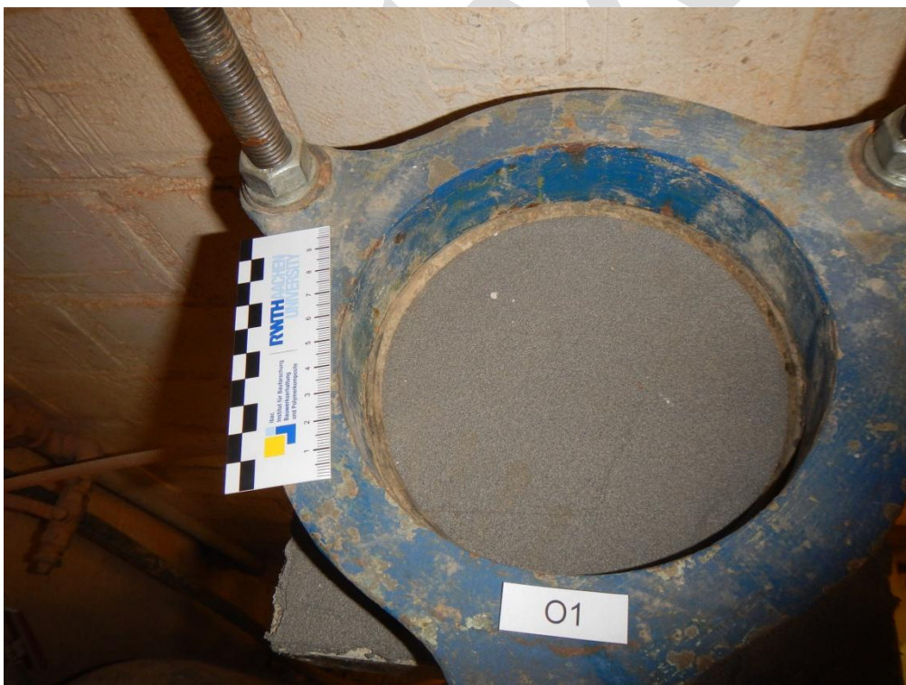
Abbildung 2: Eingebauter Prüfkörper Nr. O1 am Ende der Wasserdruckbelastung von 2 bar
